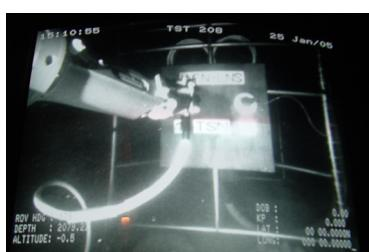
Dopo averlo posto sul fondo del mare, il frame è stato connesso al cavo ottico tramite un ROV (Remotely Operated Vehicle)
