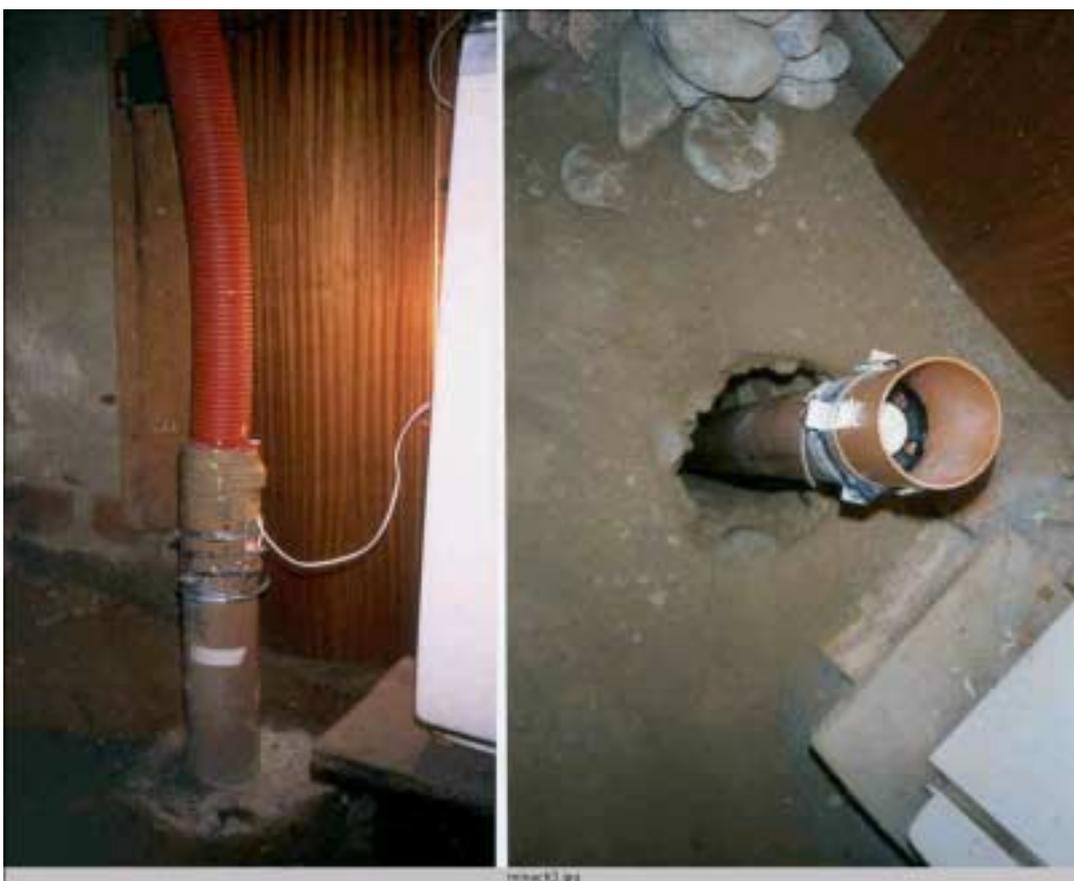
**L'immagine illustra la semplicità strutturale del sistema aspirante. A destra: il buco nel terreno della cantina e il tubo di plastica con ventilatore incorporato. A sinistra: il tubo murato alla superficie del terreno, collegato a un tubo flessibile attraverso il quale l'aria aspirata viene convogliata all'esterno.**
